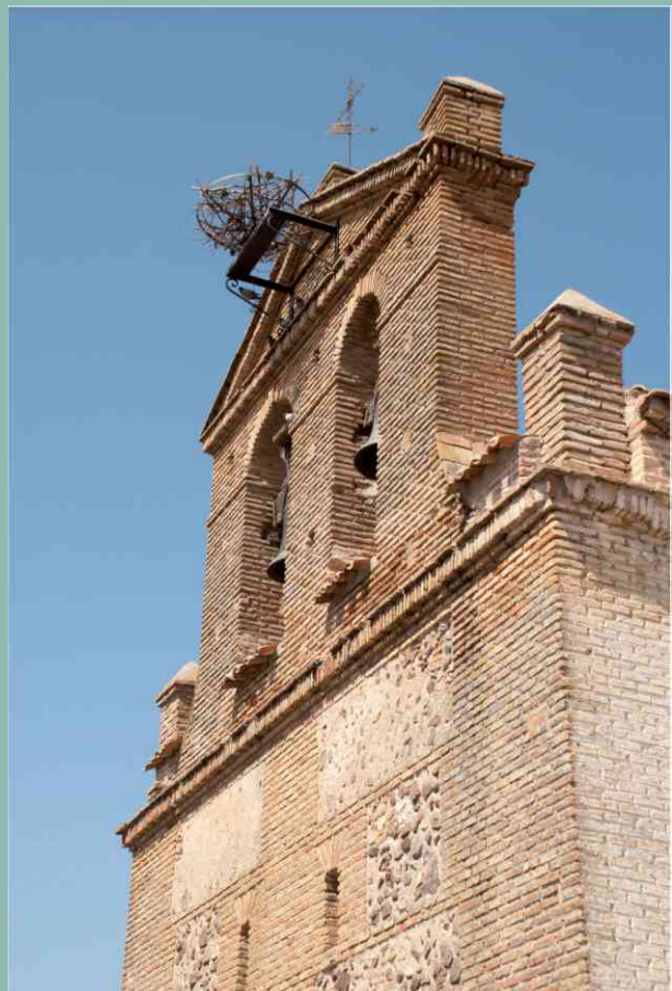
Espadaña de la fachada de los pies
