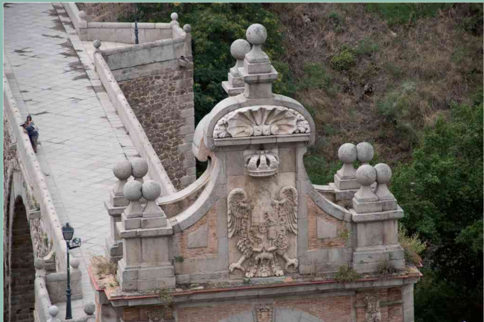
Puerta de acceso de estilo herreriano
