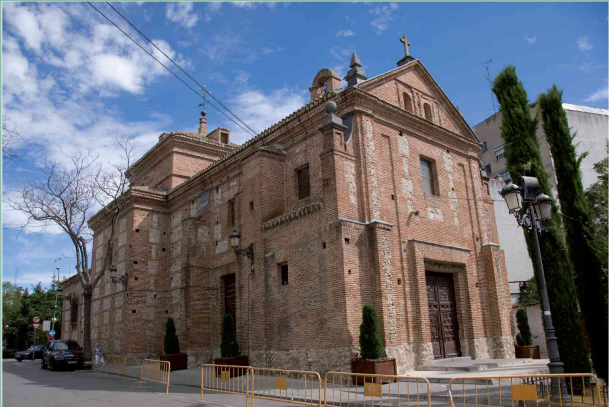
Vista general de la ermita
