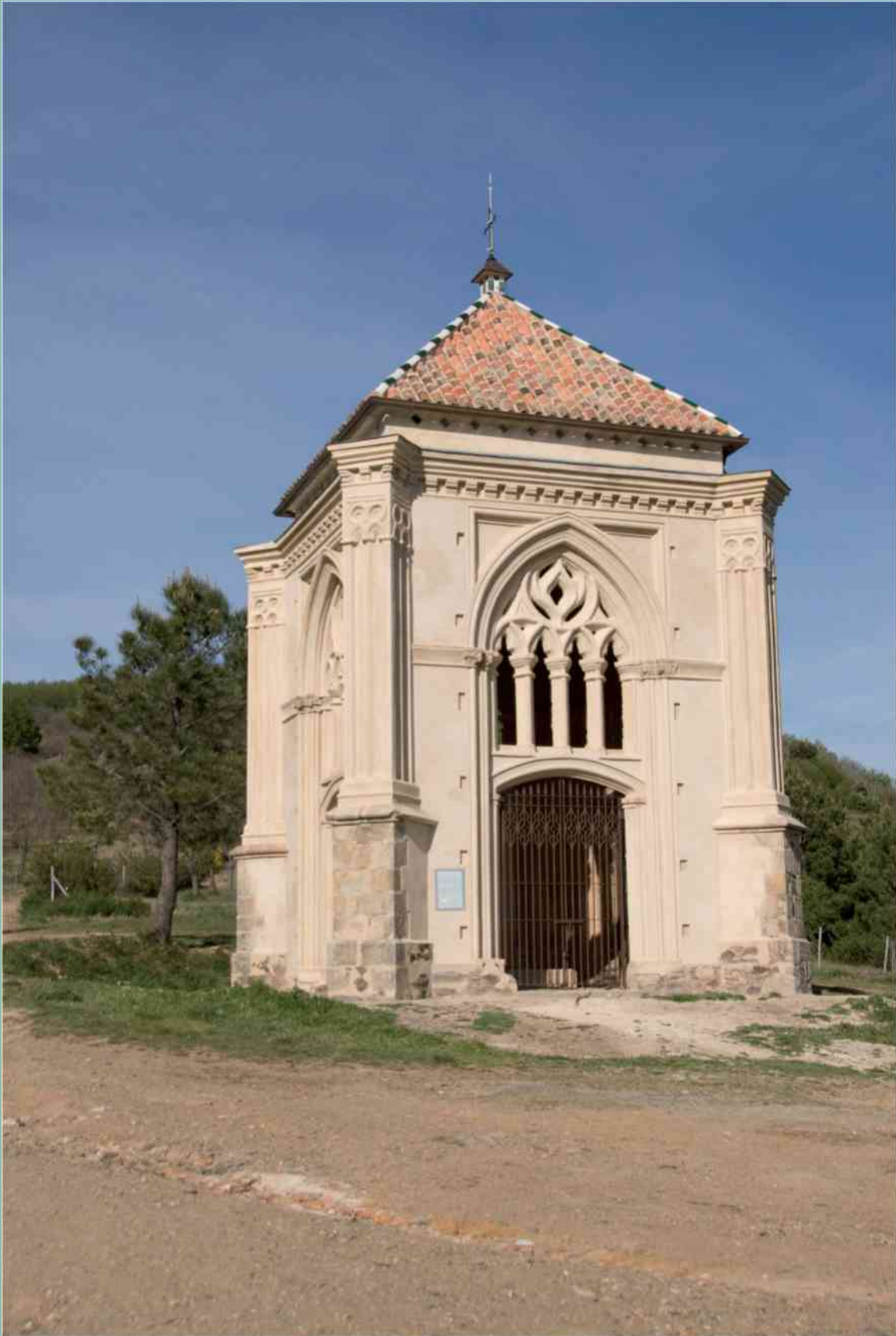
Vista general del la ermita del Humilladero
