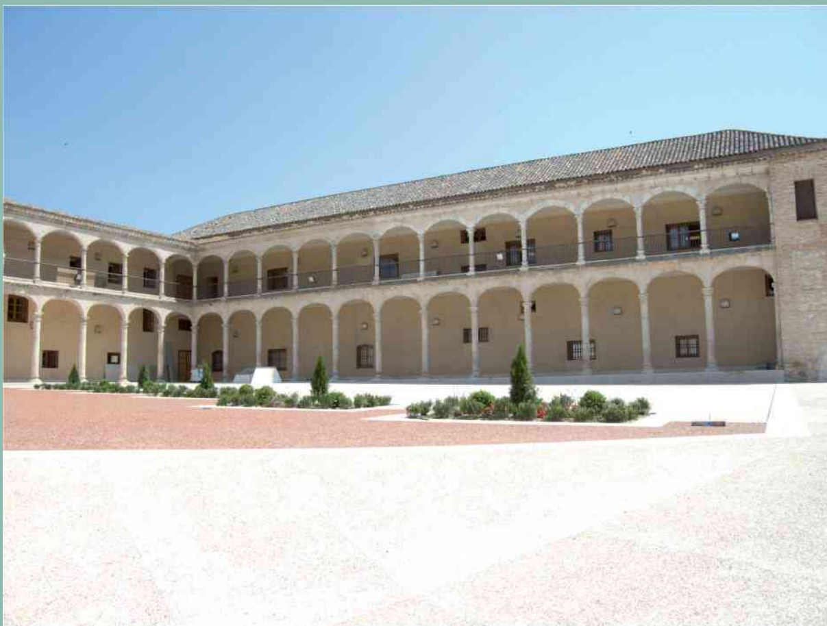
Patio porticado del edificio
