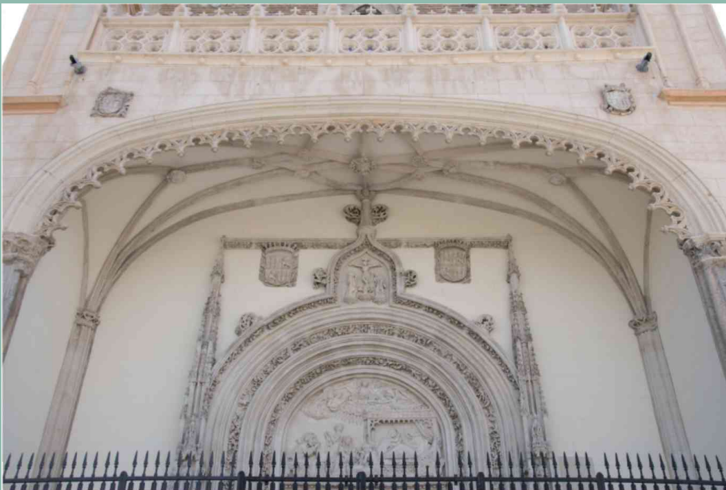
Pórtico de acceso a la iglesia (Fachada oeste)
