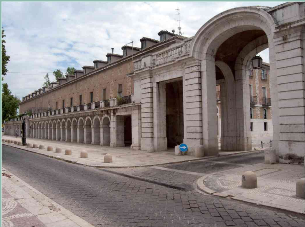
Galería porticada y arco de acceso de entrada
