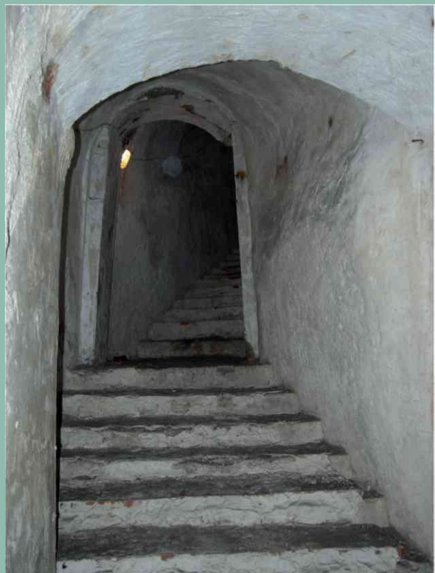
Pasadizo de acceso
