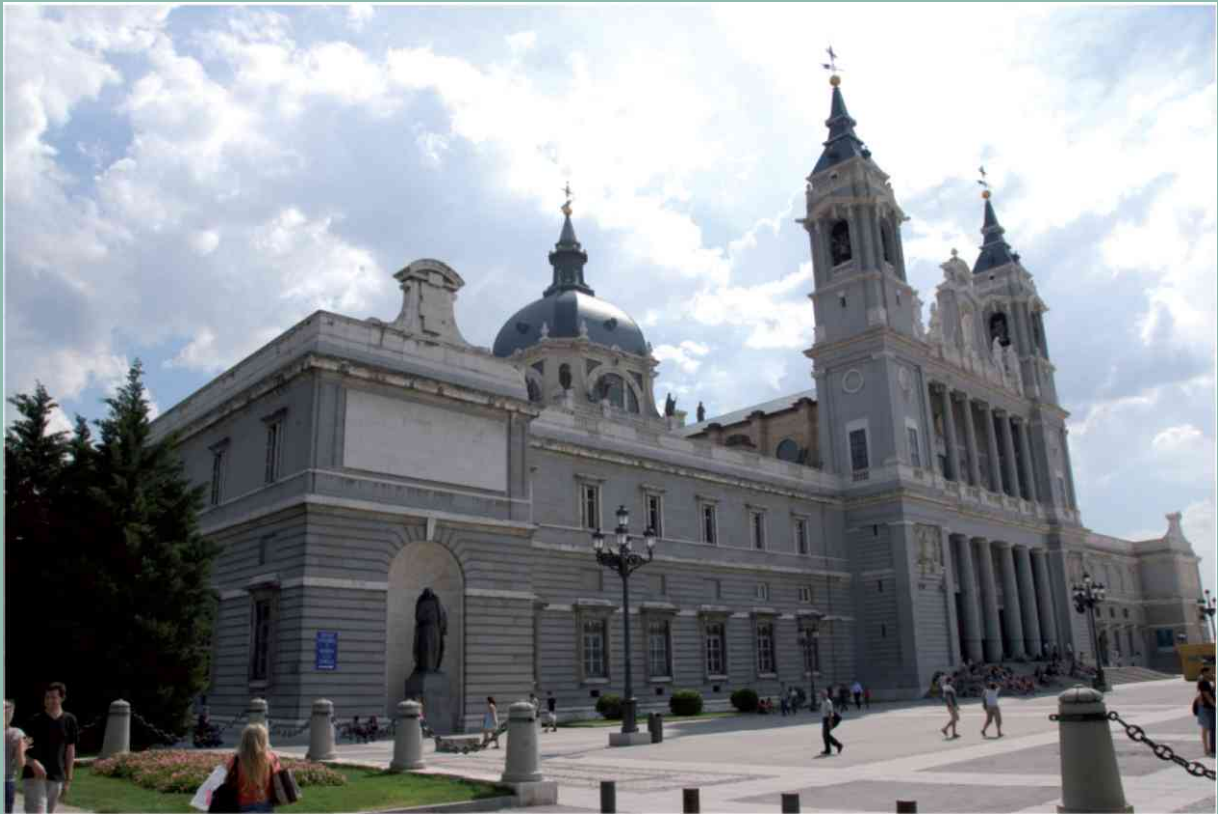
Vista general de la catedral desde la Plaza de la Armería
