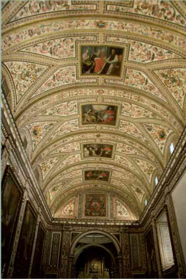
Detalle de la bóveda de la sacristía
