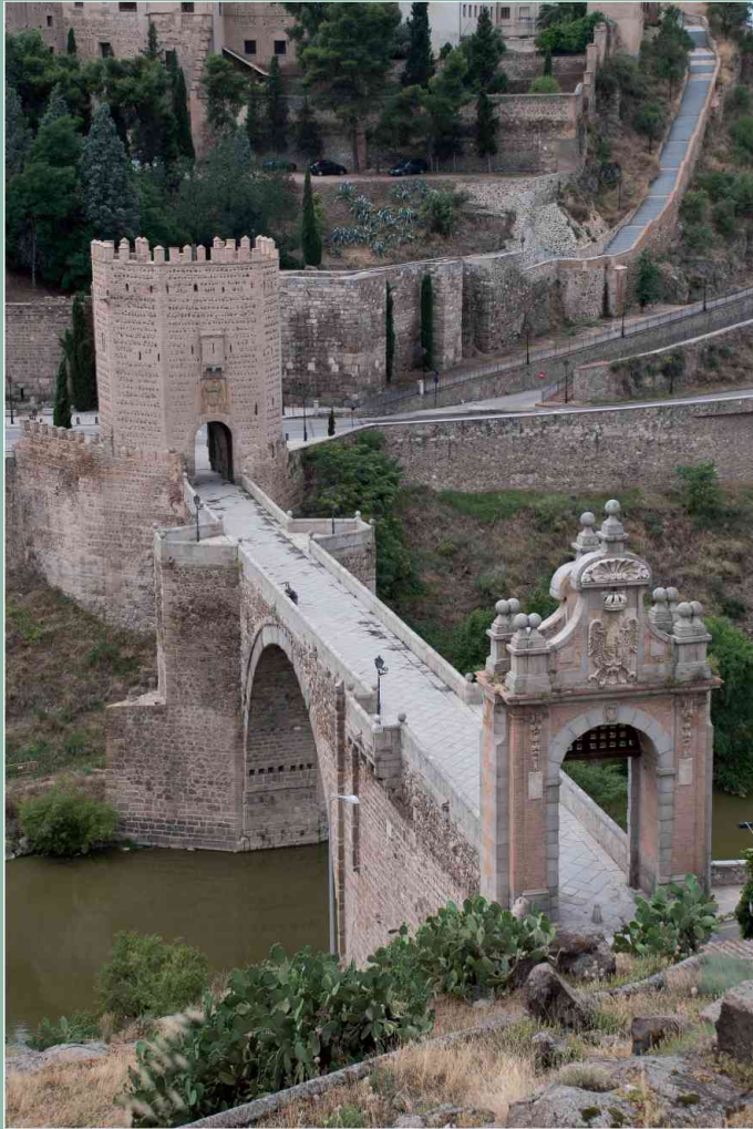
Puente de Alcántara sobre el río Tajo
