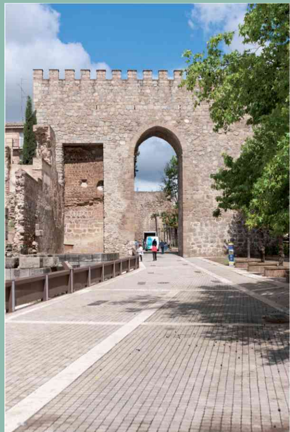
Puerta de entrada (Calle Charcón)
