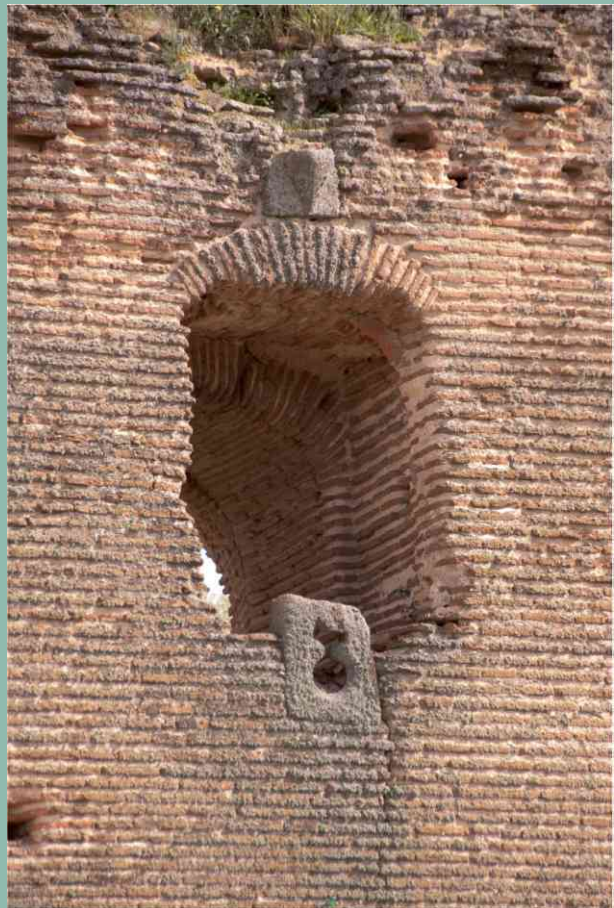
Vano y aspillera
