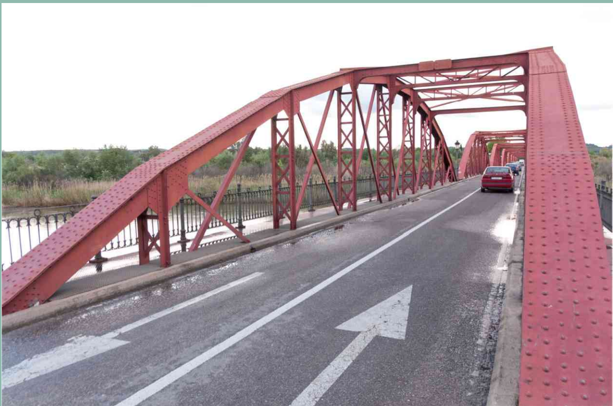
Estructura y calzada
