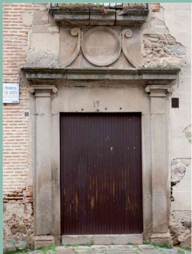
Aspecto actual de la puerta de acceso
