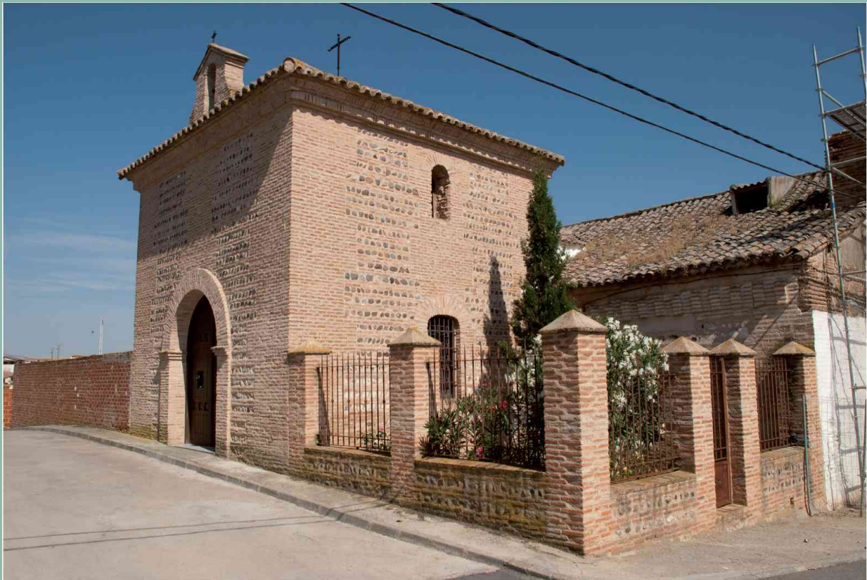
Vista general de la ermita (realizada en aparejo toledano)
