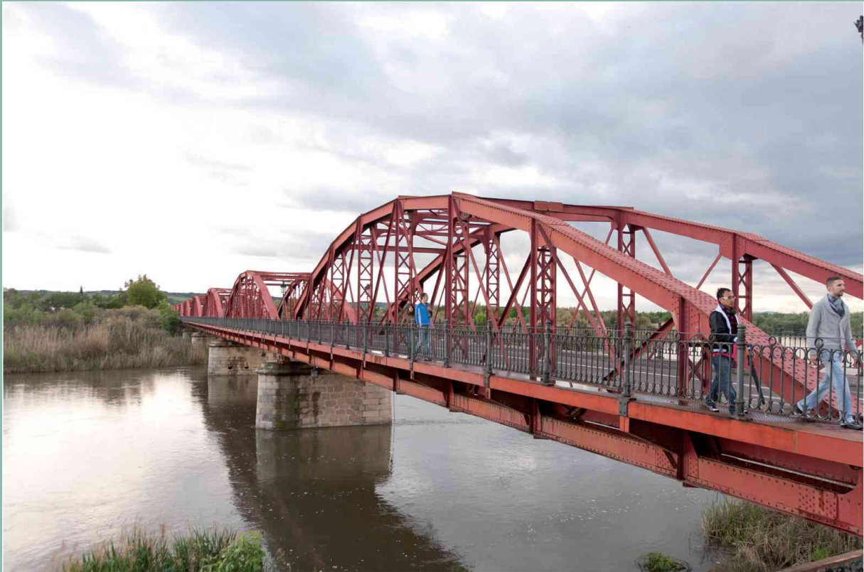
Puente de Hierro
