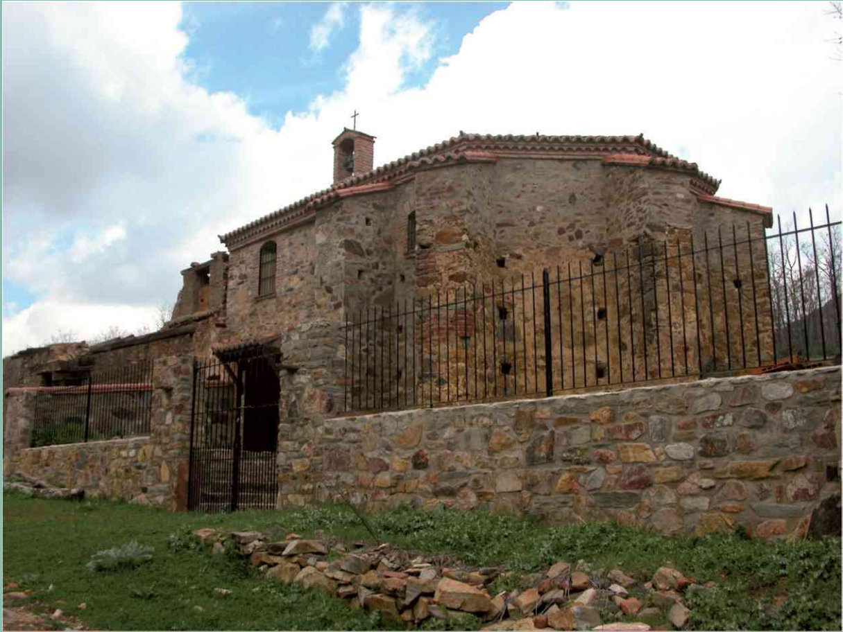
Aspecto actual del Hospital del Obispo (vista exterior)
