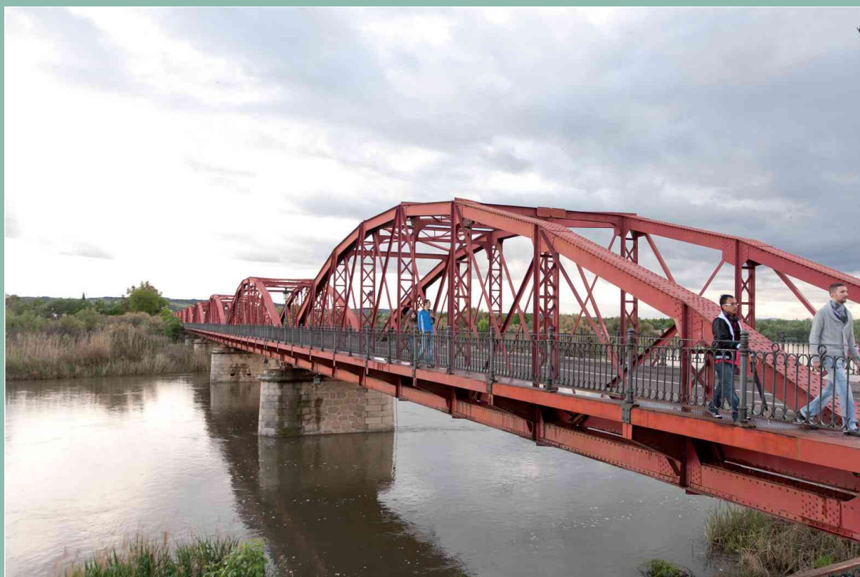
Puente de Hierro sobre el río Tajo (Talavera de la Reina)
