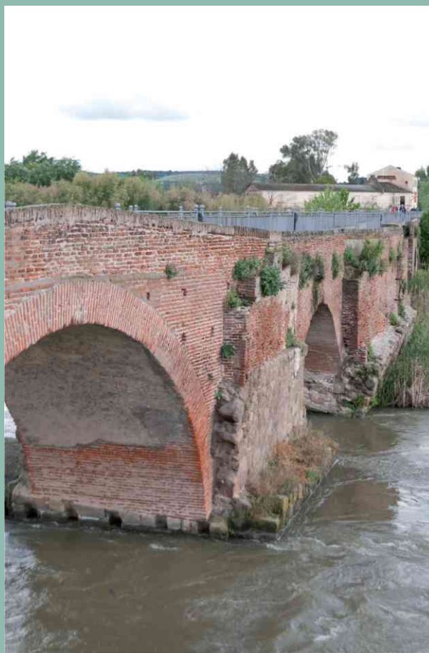
Arcos de medio punto (sillería de ladrillo)
